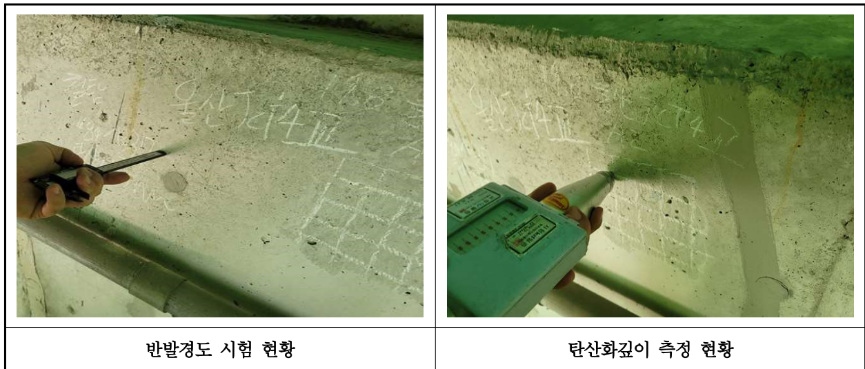
【사진 34.4.1】 콘크리트 내구성조사 현황
