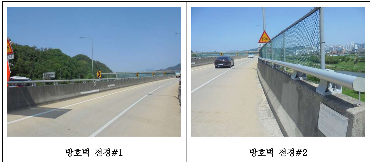
【사진 34.3.24】 방호벽 및 중분대 전경
