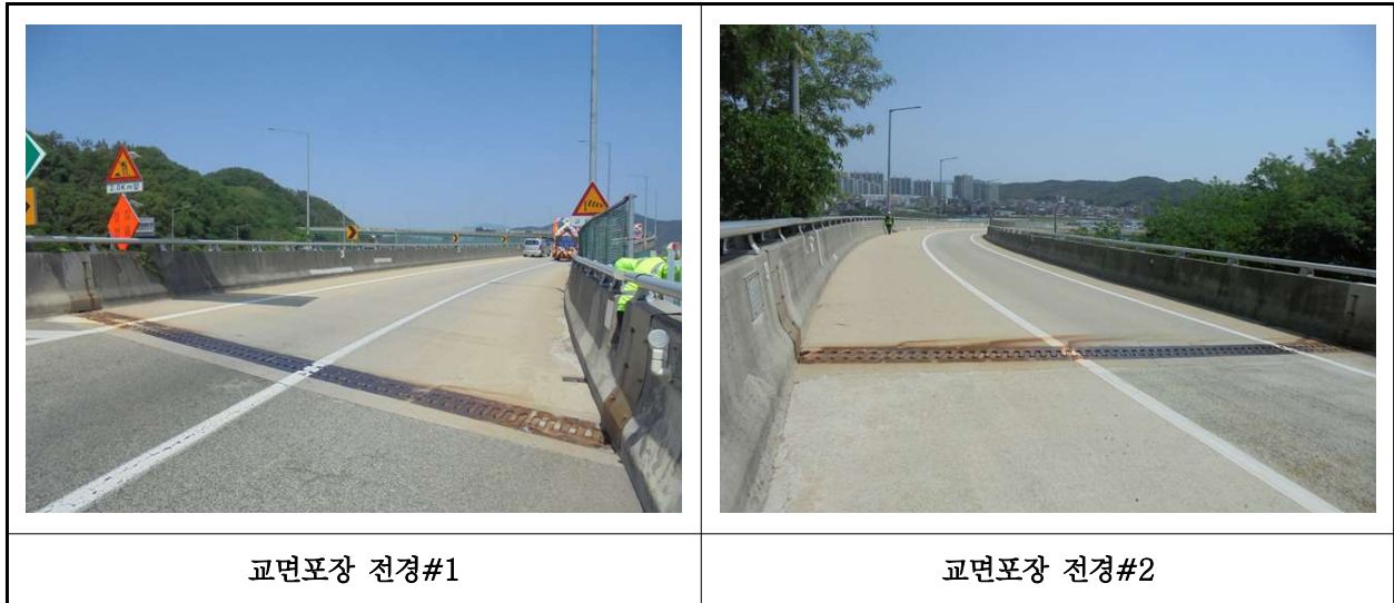
【사진 34.3.20】 교면포장 전경
