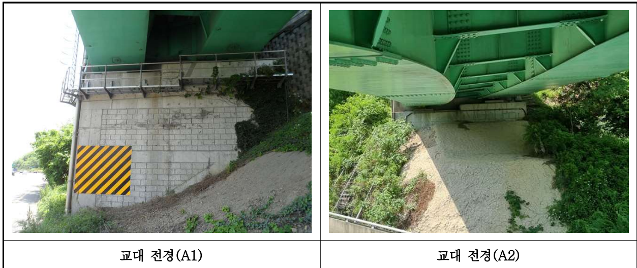
【사진 34.3.8】 교대 전경
